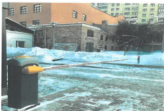
Внешний вид шлагбаума (габариты стрелы: 60x80x3850 мм)
